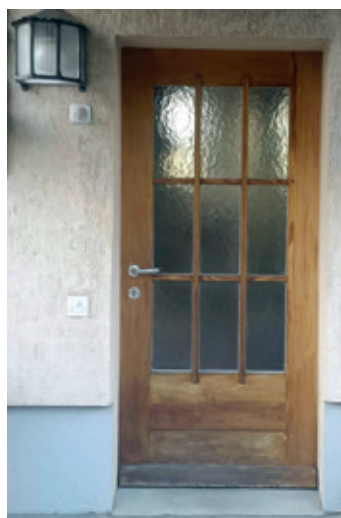
Die 50-jährige Haustüre mit Einfachverriegelung wird durch eine neue Türe mit 5-fach-Verriegelung ersetzt. Das sorgt für erhöhte Sicherheit.
