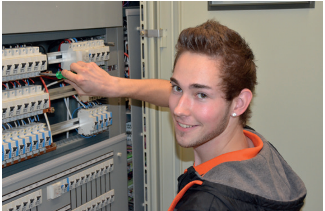
Simon Zemp, angehender Elektroinstallateur, beim Verdrahten einer Elektroverteilung am Tableau.
