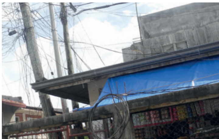
Kabelsalat: Vielerorts wurden neue Stromkabel aufgehängt. Die Zeit reichte offenbar noch nicht, um die alten Kabel abzuhängen.
